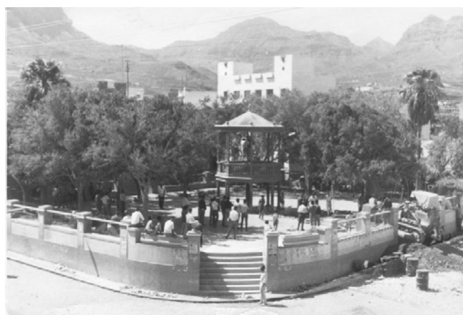
Agosto de 1966, cuando un tractor de oruga entra en La Alameda para derribarla e iniciar las obras de otra plaza.
